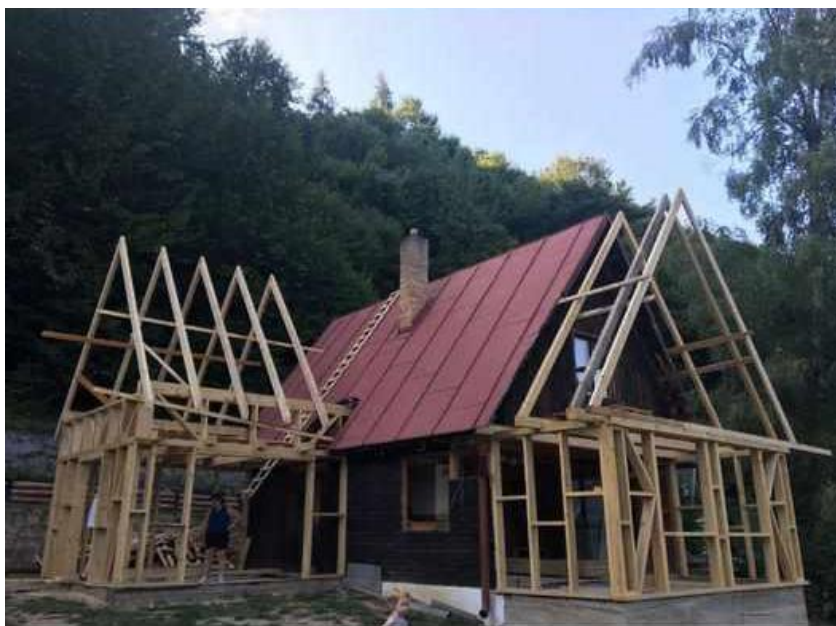
Stavba chaty – Stará Ľubovňa – 18.8.2022
